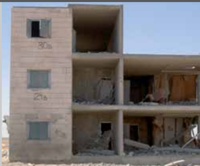
Edificio colpito da un esplosione provocata da 830 kg di TNT.
