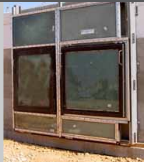
I serramenti hanno perfettamente resistito all'esplosione.
